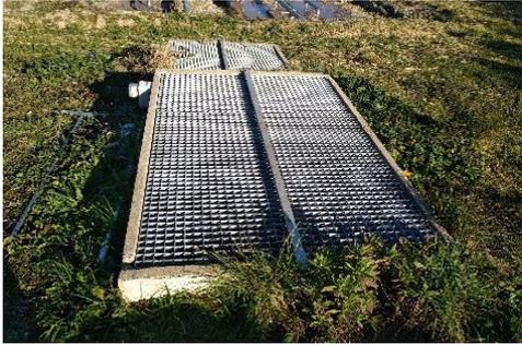
Grille droite intégrée dans l'ouvrage de siphonage
